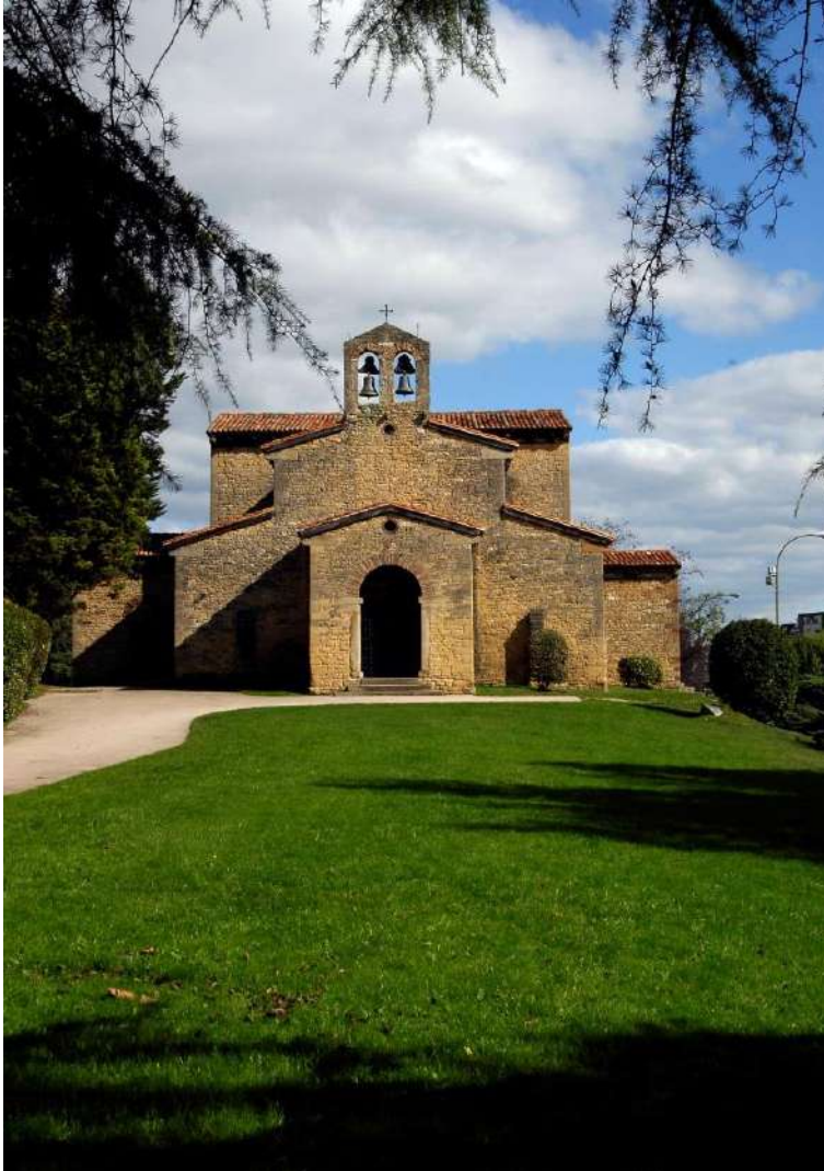
Fachada Oeste de Santuyano. Fotografía de Lorenzo Arias.
